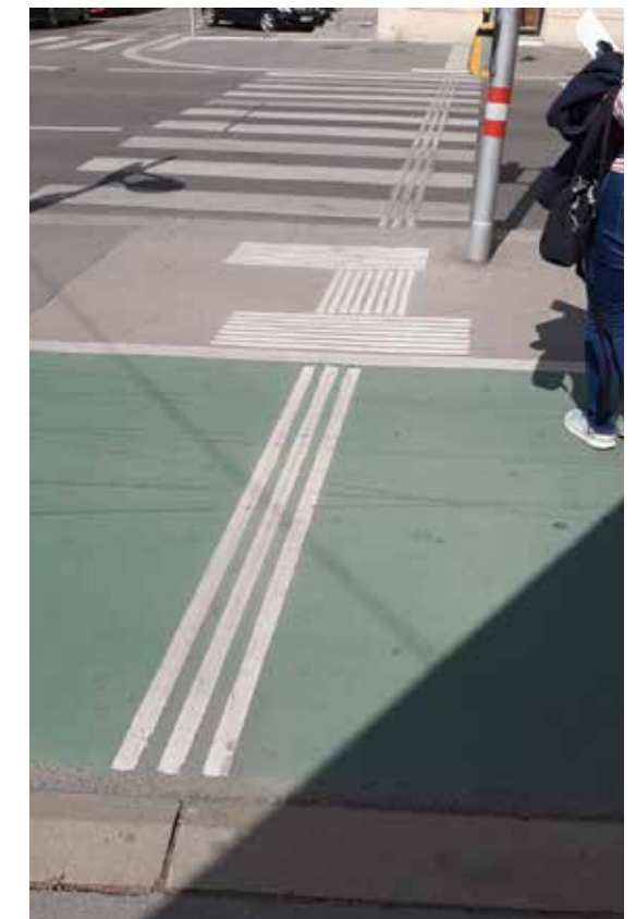
1010 Wien, Kreuzung Nibelungengasse/Operngasse: Kein Zebrastreifen, Blindenleitweg kreuzt Radweg.
